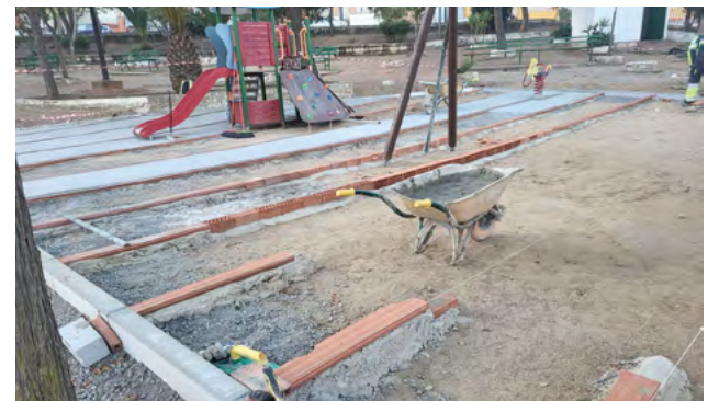
Actuaciones que se están realizando en este espacio
